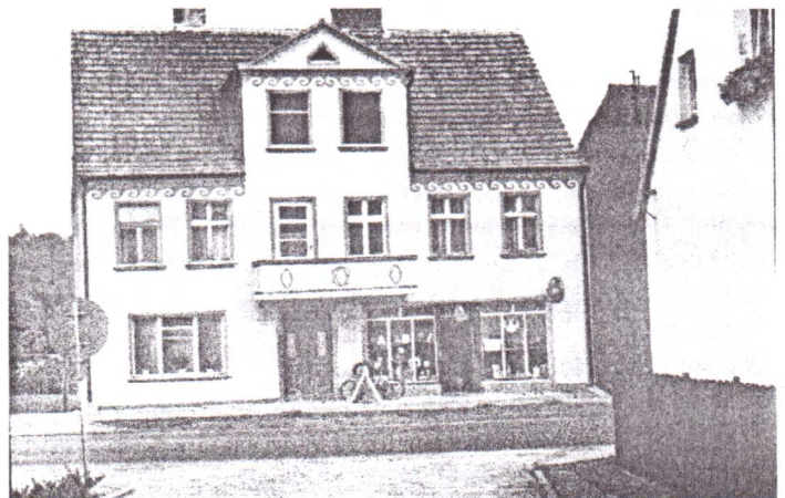
Wyremontowany budynek przy ulicy Wolności 44, będący własnością Pani Krystyny Ulicznej.
